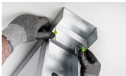
Abbildung 3: Gleitender Deckenanschluss
